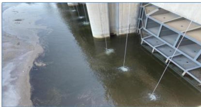
图 4 闸门微气泡防冰冻应用
